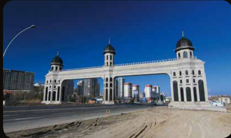
Eskişehir Yolu Giriş Kapısı
